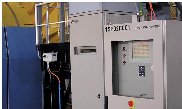
устройство оснащено местной и дистанционной аварийной сигнализацией. Конфигурацию алгоритма аварийной сигнализации можно выполнить так, чтобы сигнал тревоги срабатывал лишь в случае, когда вмешательство обслуживающего персонала необходимо, и не «беспокоил» при небольших отклонениях измеряемых токов от установленных пределов.
